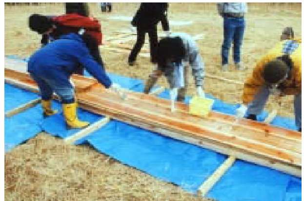
上3枚は、「建設」風景。一番下は、防水などを目的とした柿渋ぬり。
