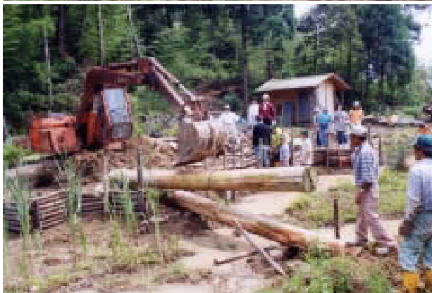
上:作業前 下:作業途中
