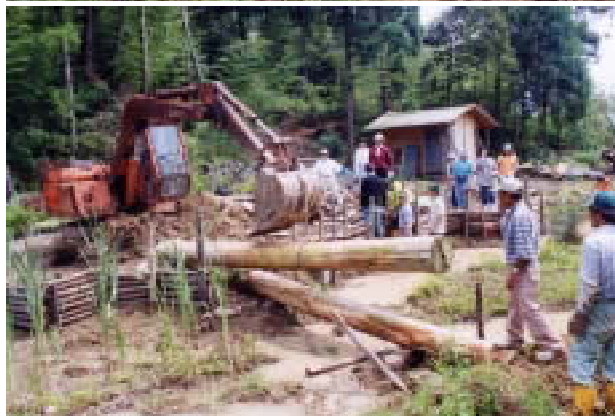
上:作業前 下:作業途中
