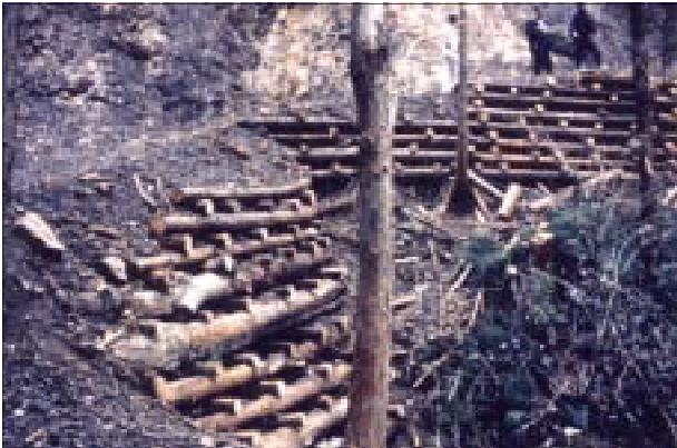
高知県大正町上岡シデノ木山作業道
