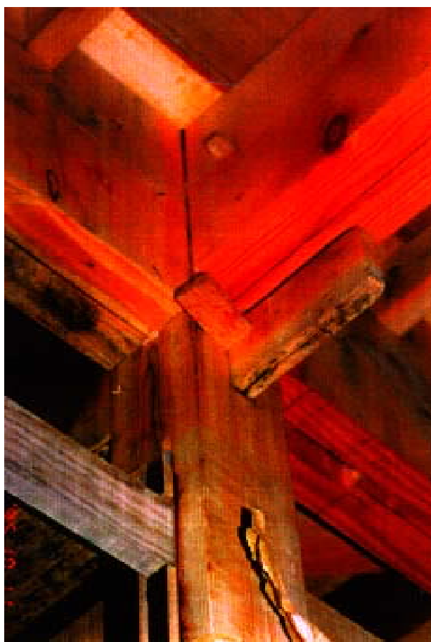
【伝統的な柱と梁の接合部】
